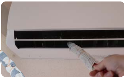
エアコン菜箸。菜箸に使い捨ての布を巻き付けて使います
